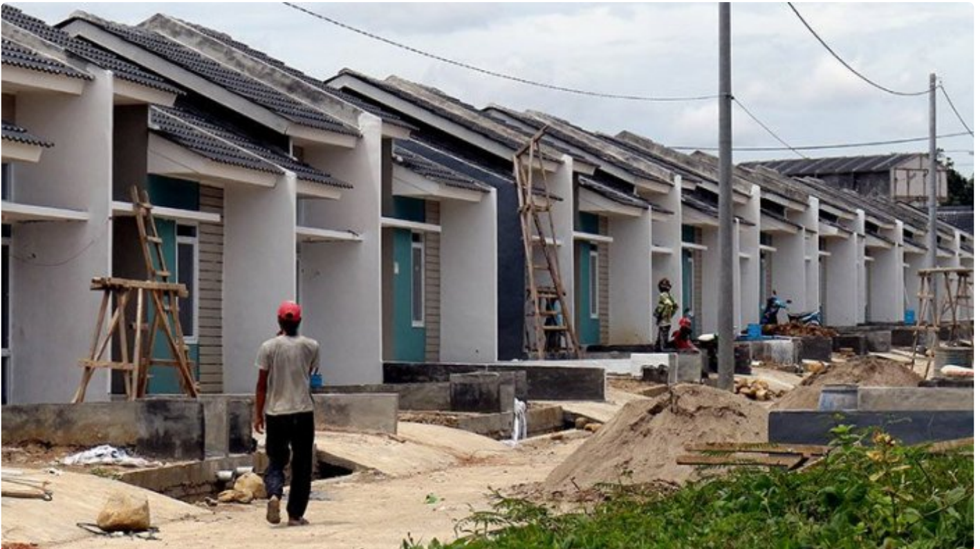
Pembangunan rumah subsidi di Citeurep, Kabupaten Bogor. Jawa Barat
